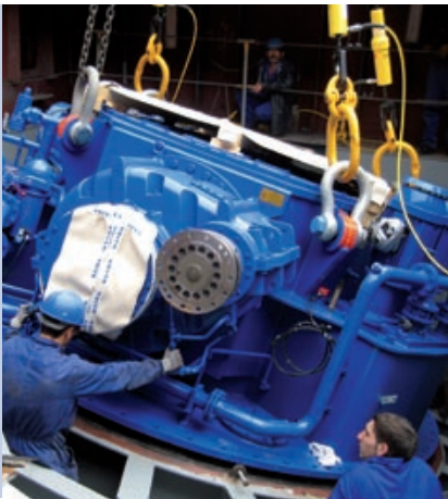
Voith Schneider Propeller installation
